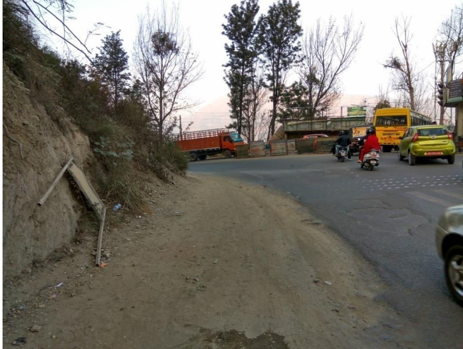
Fig 1.5(d) Shimla-Chandigarh highway (NH-22)
