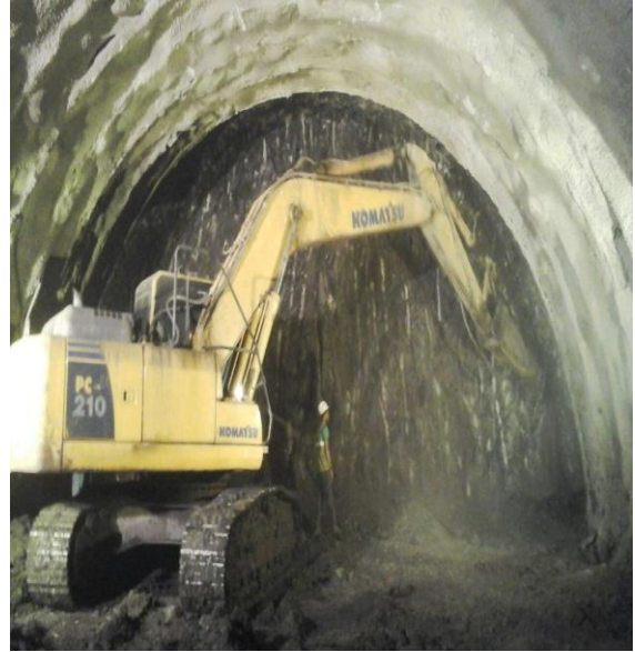
Figure 3.4 (d) Tunnel construction
