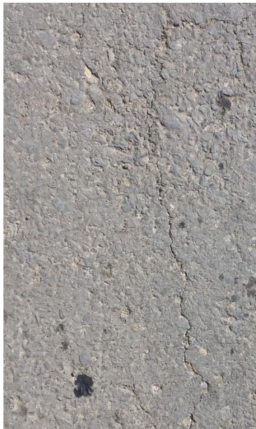
Fig. 4. 10 Longitudinal cracking
